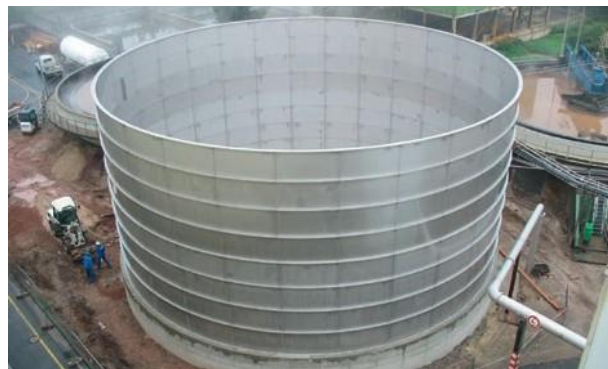
1.661 m 3 Nádrž na odpadní vodu pro papírenský průmysl 1,661 m 3 Waste water tank for the paper industry
