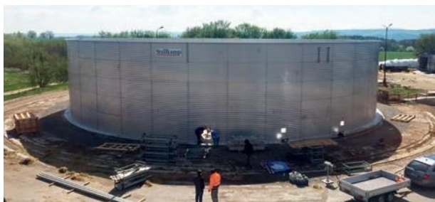
6,283 m 3 Nádrž z vlnitého plechu v České republice (Hlavnice) 6,283 m 3 Corrugated steel tank in the Czech Republic
