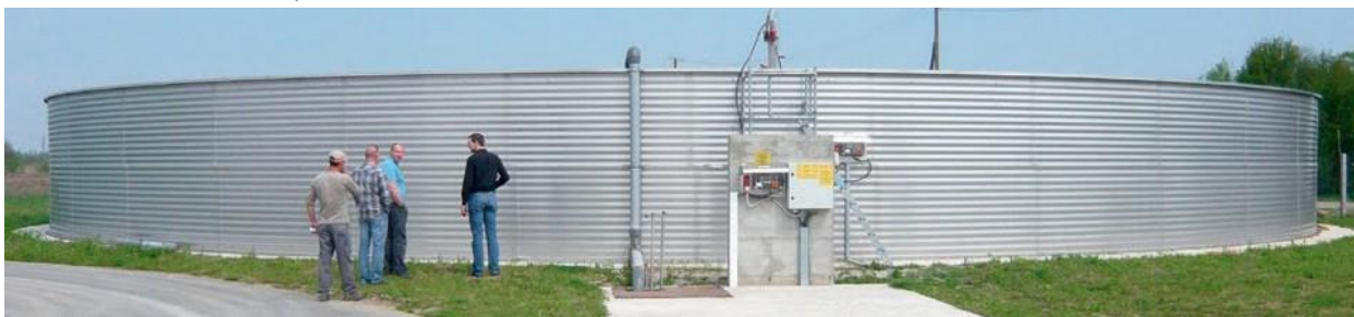
Nádrž z vlnitého plechu v Chorvatsku Corrugated steel tank in Croatia
