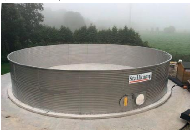
572 m 3 Sklad čistírenských kalů z vlnitého plechu 572 m 3 Waste water storage made from corrugated steel
