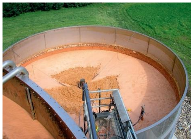
Nádrž na odpadní vodu Waste water tank
