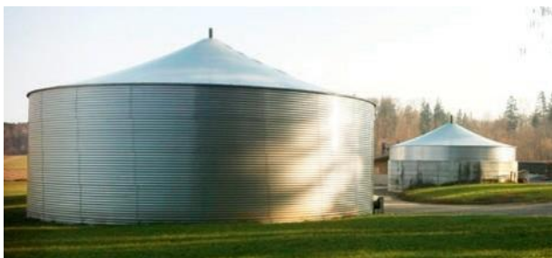
Nádrž z vlnitého plechu a zvýšená betonová nádrž s nerezovým plechem Corrugated steel tank and heightened concrete tank with corrugated steel tank
