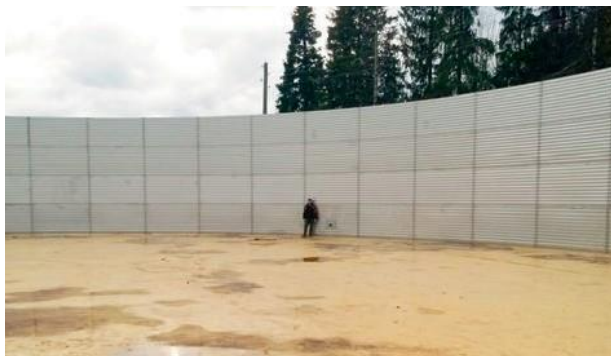
8,559 m 3 Největší instalace nádrží z vlnitého plechu (Rusko) 8,559 m 3 The world's largest corrugated steel tank made of stainless steel
