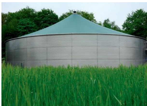
Nádrž z vlnitého plechu s membránovou střechou Corrugated steel tanks with a membrane roof
