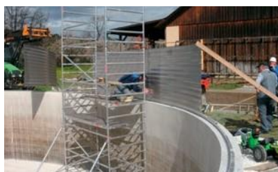
Zvýšení nádrže Adding height to a tank
