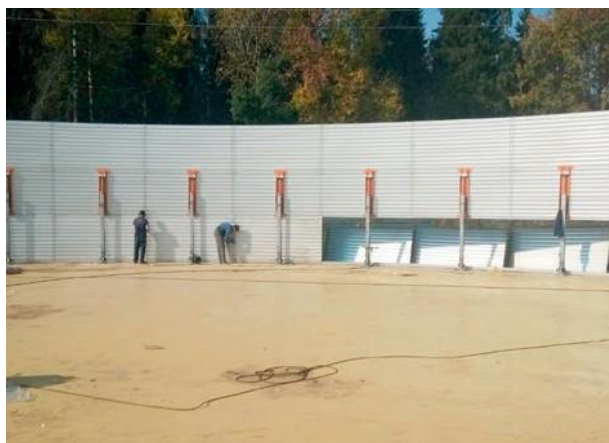
Montáž se zvedacím zařízením Assembly with lifting gear
